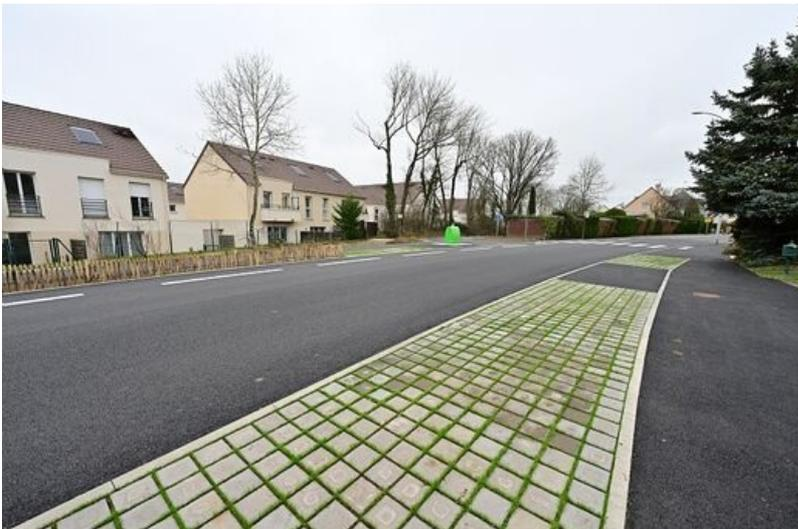
L'exposition insiste sur les revêtements perméables pour la réalisation de voies de circulation. Ils permettent l'infiltration de l'eau de pluie comme pour ces trottoirs aménagés fin 2023 rue du Villaret, au Mans.
