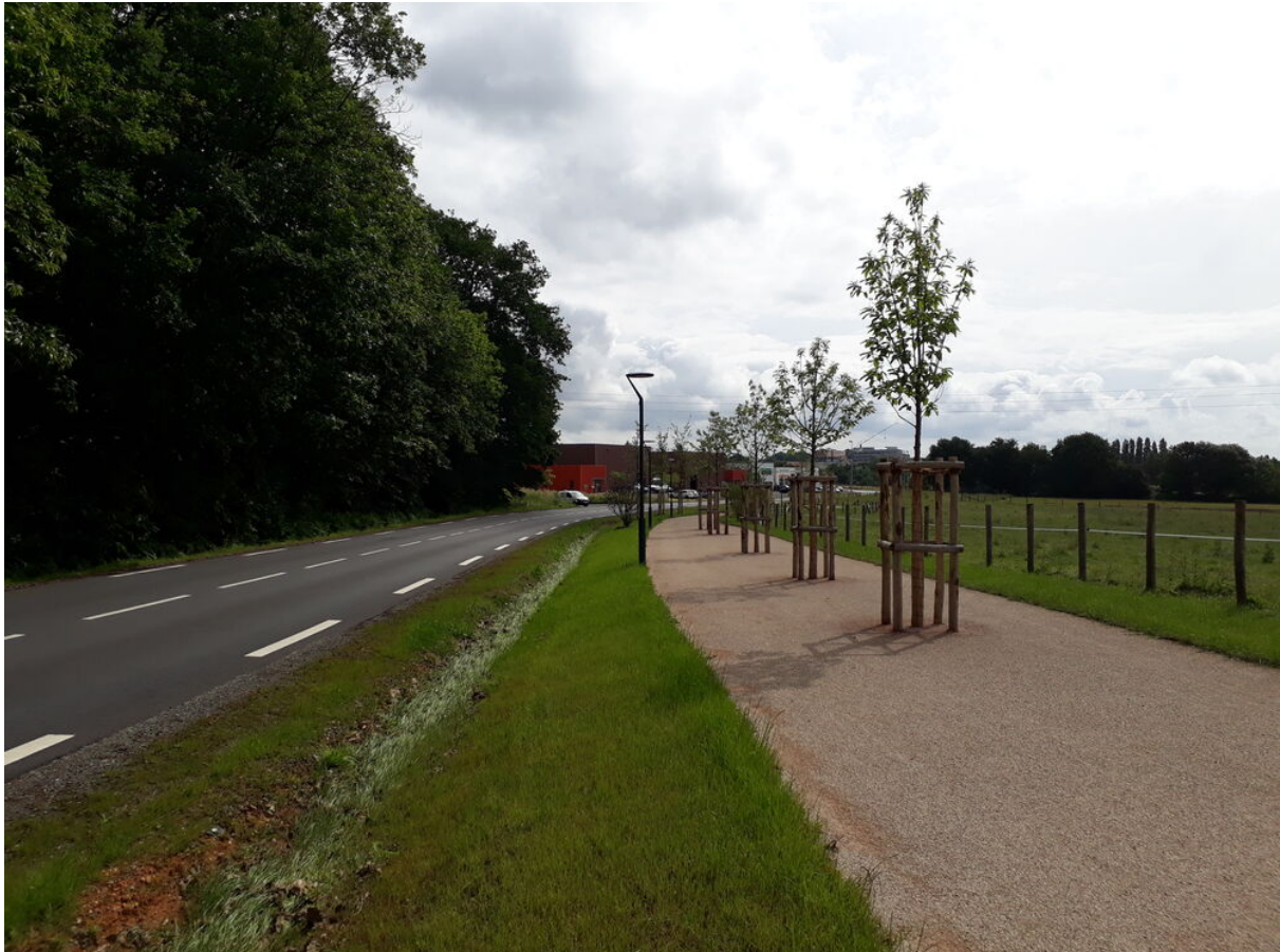
La voie verte créée le long de la VC 246.
