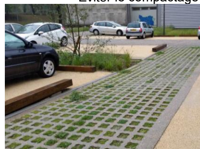
Pavé joints gazon
