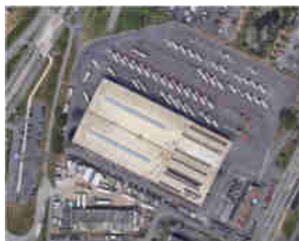
Figure 23 : Le dépôt de la SETRAM au Mans
