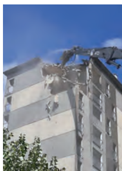
ALLONNES - Immeuble Chabrier en démolition
