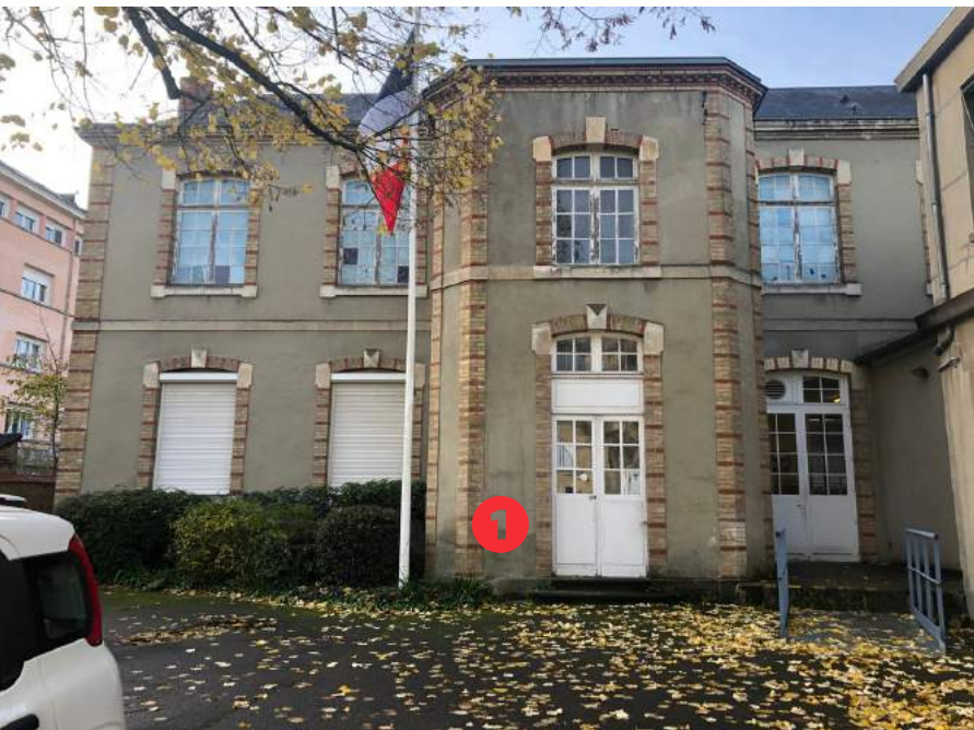
Vue du bâtiment principal
