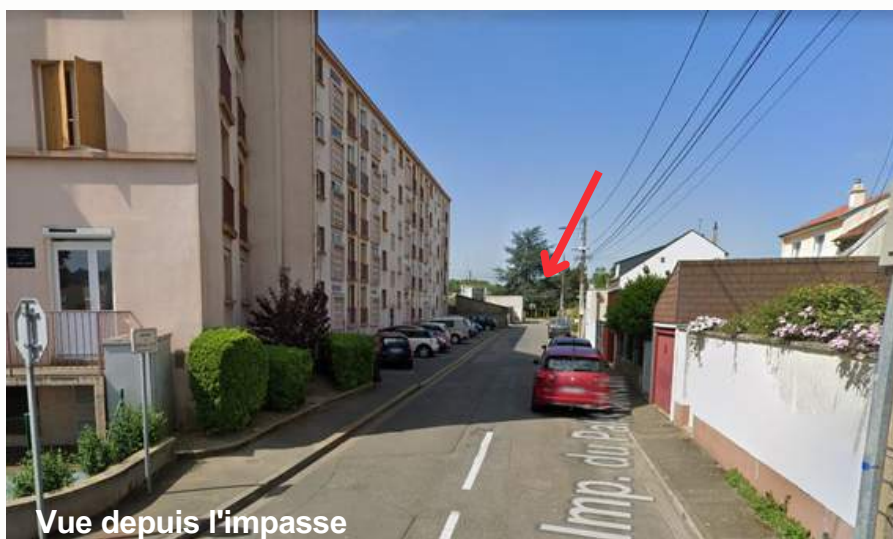
Vue du bâtiment de bureau existant
