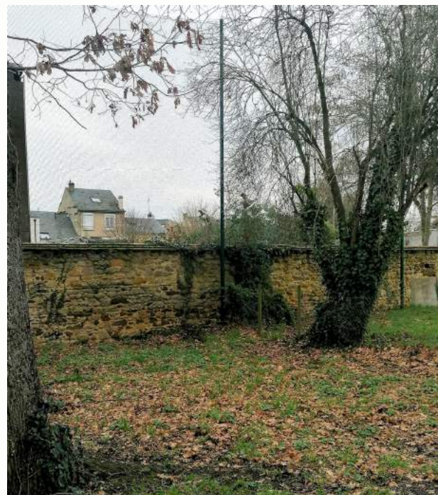
Mur en pierre au Nord du square
