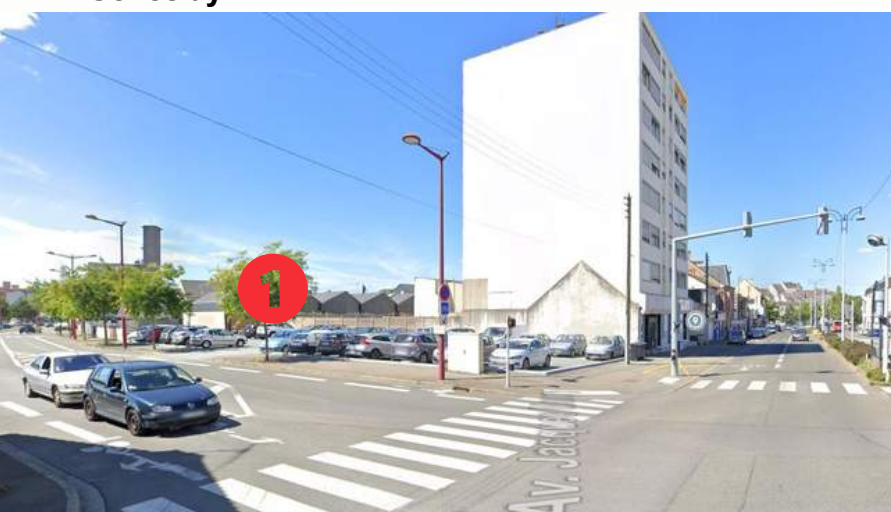
Photo prise depuis l'avenue Felix Geneslay sur le parking situé au Nord
