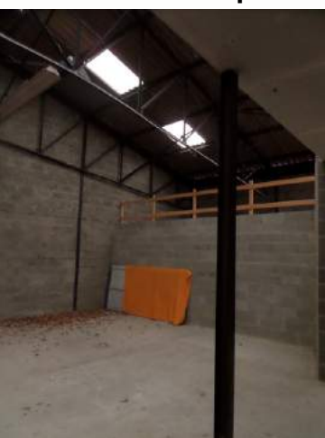
Intérieur du hangar
